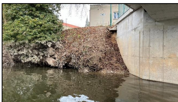
Pohled na podemletí a degradaci břehu u mostní konstrukce v období 11/2024
