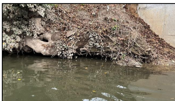
Pohled na podemletí a degradaci břehu u mostní konstrukce v období 11/2024
