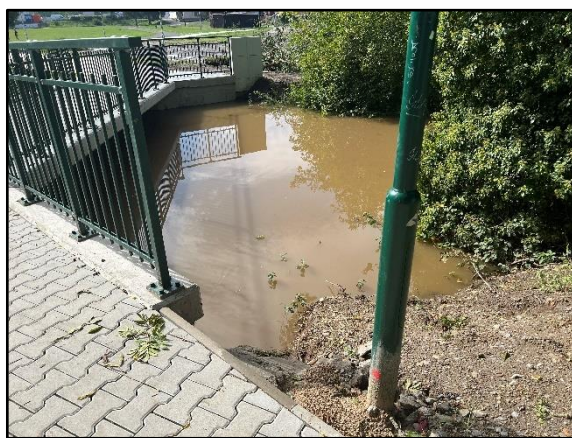
Pohled na vtok a výtok u mostní konstrukce v době povodně 09/2024 a vliv vzdutí toku Labe
